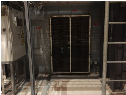
ชุด Silencer ของ Gas Turbine
